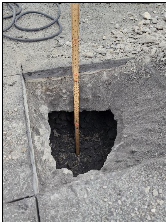
Obr. č.8 – sonda do střešního pláště ve hřebeni střechy
